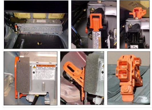
Görsel 4.8: Elektrikli Araçlarda Yüksek Gerilim Servis Tapaları
